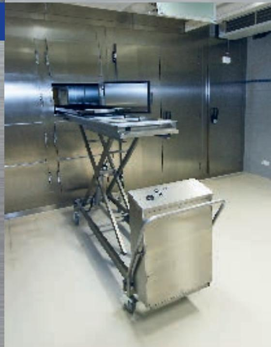
Leichenkühlanlage mit elektro-hydraulischen Leichenmuldenhubwagen, Beschickung und Entnahme
