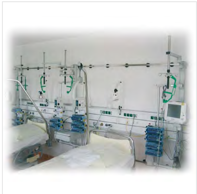
Befestigung an Wandversorgungskanal und Normschiene auf der Intensivstation
